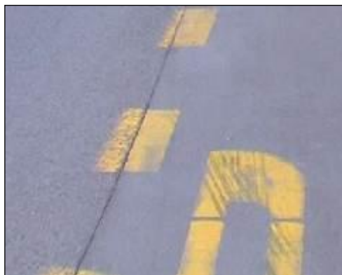
Slika 3.2: Razpoke - Vzdolžna razpoka
