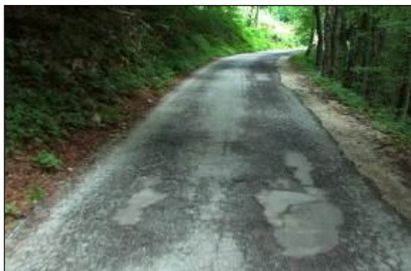
Slika 3.6: Krpe - Deformirano hladno krpanje
