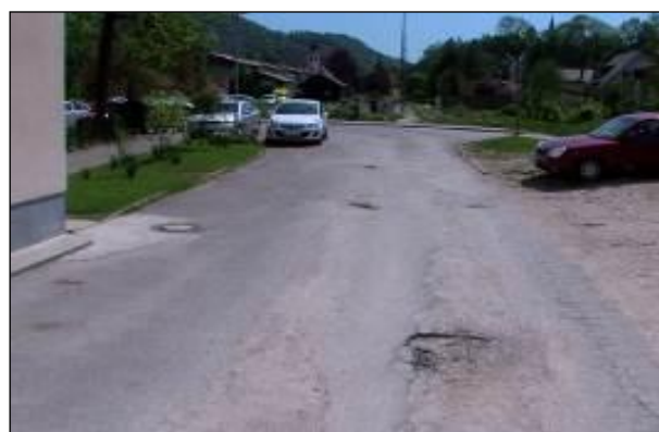
Slika 3.9: Udarna jama globoka nad 5 cm premera
