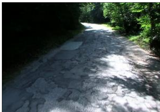
Slika 3.5: Obraba - Luščenje obrabne plasti
