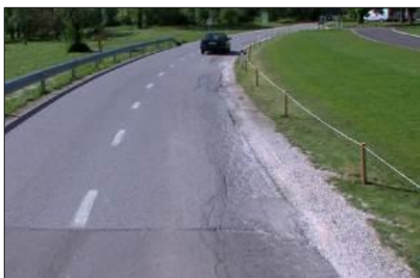
Slika 3.8: Udarna jama v nastajanju
